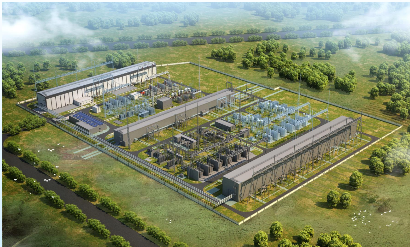
#1 500kV GIS室（含继电器室）
